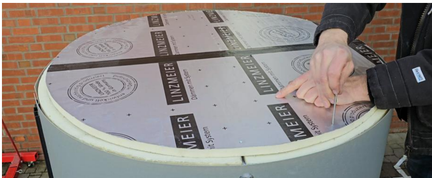
4) zweiter PU-Deckel 20mm, mit Stahlstiften sichern
