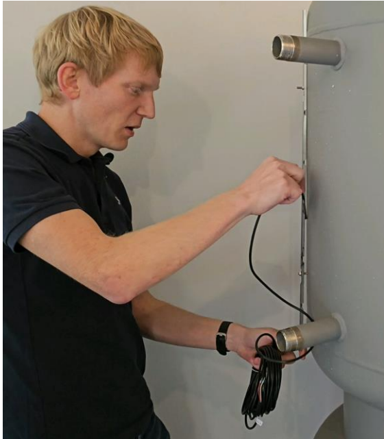
Fühlerpositionierung
