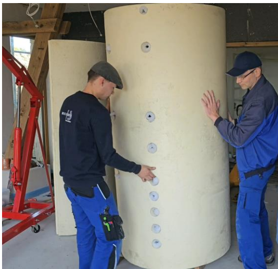
Entfernung der PU-Halbschalen und der Zwischenisolierung bzw. Isolierringe
