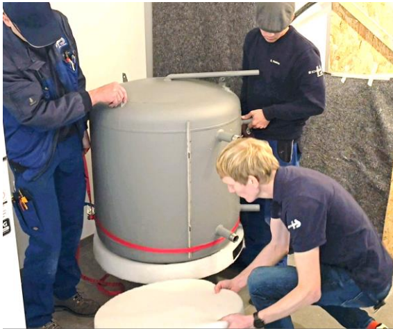
Einbringung der unteren Dämmung
