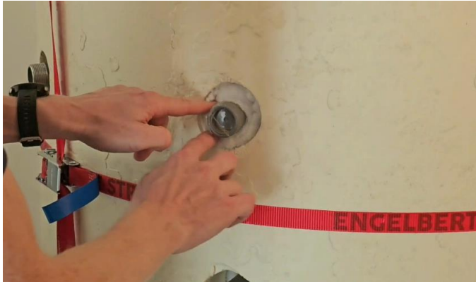
Einsetzen der Vliesringe / Stopfwolle
