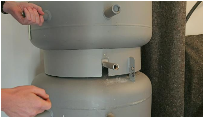
Aufsetzen des oberen Speicherteile und verschrauben beider Speicherteile
