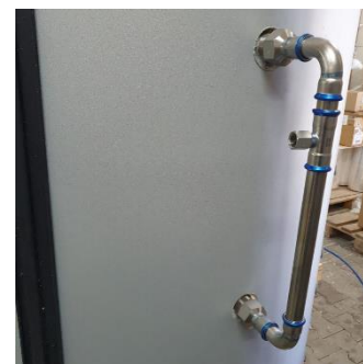
Montage der Warmwasserbrücke
