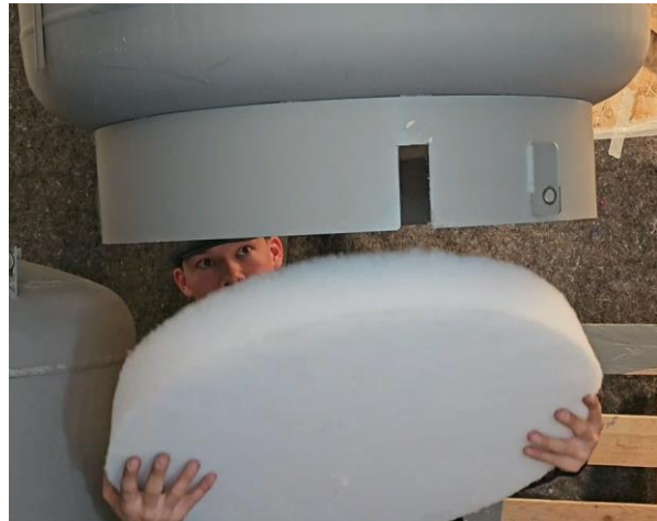
Einbringung der mittleren Dämmung
