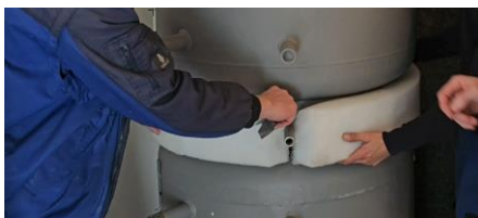
äußerer (mittlerer) Vliesring
