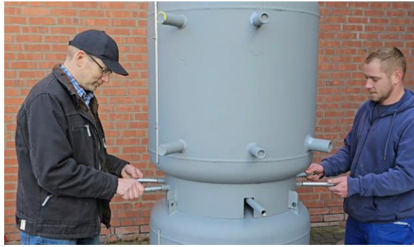
Abheben des Speichers mit Einschraubgriffen ½"
