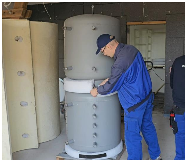
Entfernung der PU-Halbschalen und der Zwischenisolierung bzw. Isolierringe
