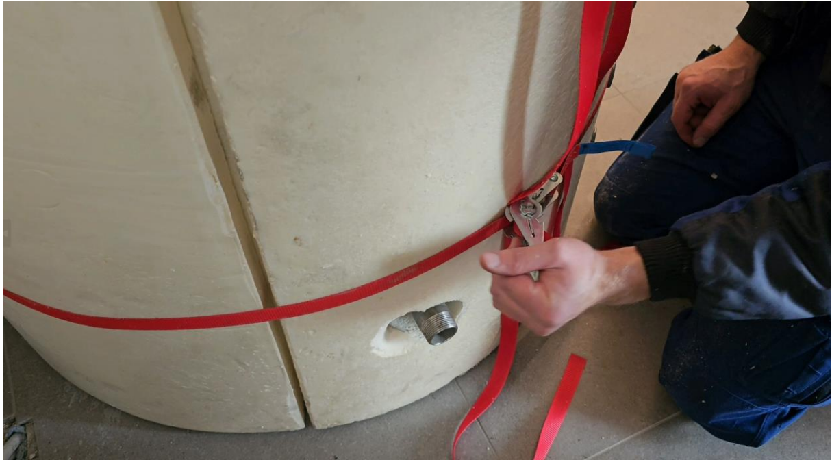
Gleichmäßiges zusammenziehen der PU-Halbschalen mit 3 Spanngurten
