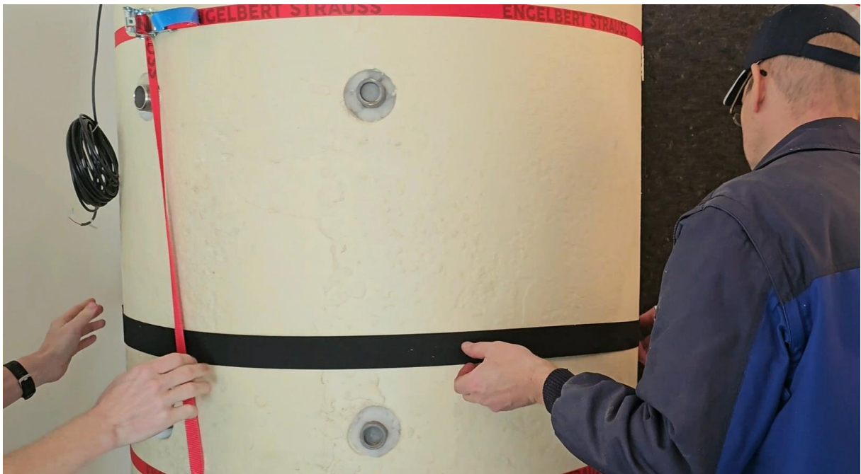
Montage der mitgelieferten Gurte und lösen der Spanngurte
