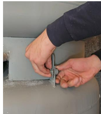
Aufsetzen des oberen Speicherteile und verschrauben beider Speicherteile
