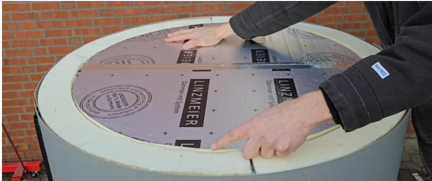
3) Erster PU-Deckel 20mm
