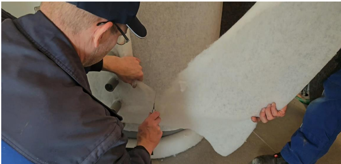
Vlies um den Speicher legen und ablängen
