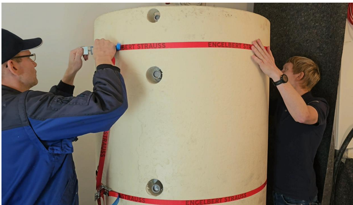
Montage der PU-Halbschalen
